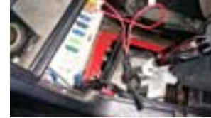
Strömbrytare som styr den otillåtna elektroniska varvtalsregulaton.
