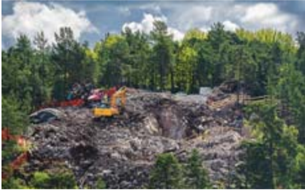
Tunnelmynningen i Ryssbergen.
