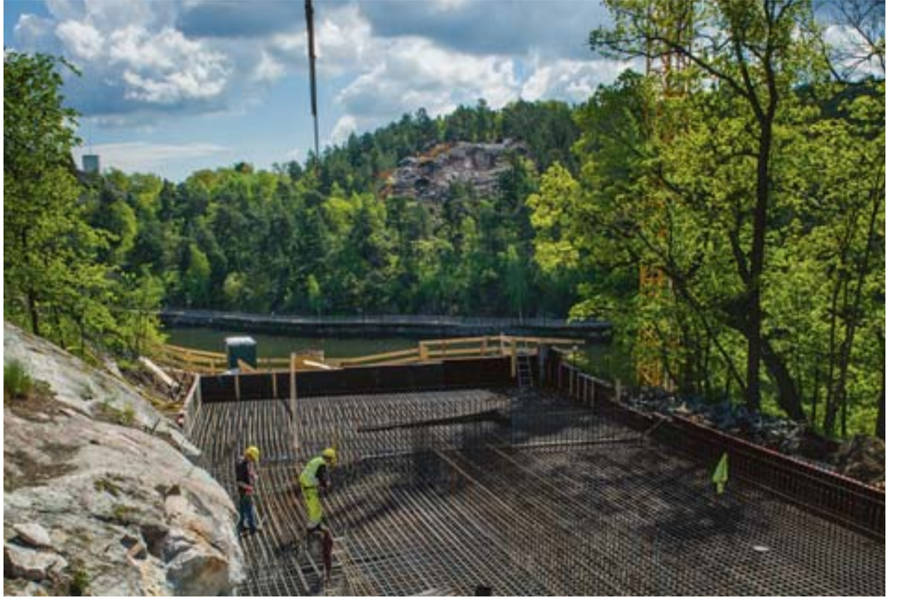
Fundamentet på Kvarnholmen kommer att bära en större del av bronns vikt.
