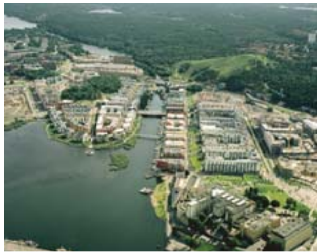
Så här såg de centrala delarna av Sjöstaden ut från luften 2005.
